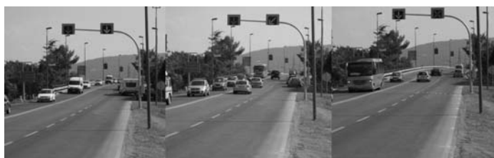
Slika 4: Smanjenje broja vozničkih traka upotrebom saobraćajnih znakova sa promenljivom sadržinom i svetlosnom signalizacijom za dinamičko raspoređivanje vozničkih traka koje se bazira na podacima iz video nadzornog sistema.
