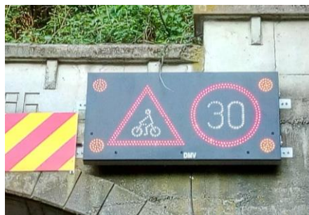
Slika 7: Dopunska signalizacija u tunelu
