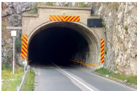
Slika 1: Dopunska signalizacija u tunelu
