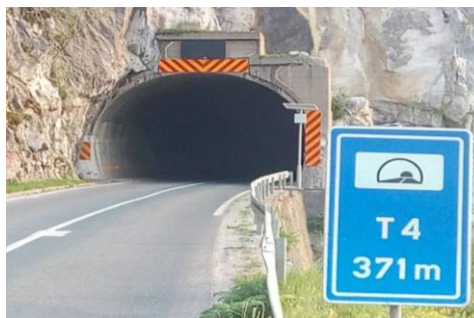
Slika 3: Dopunska signalizacija u tunelu T4
