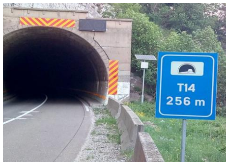
Slika 4: Dopunska signalizacija u tunelu T14
