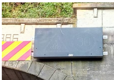
Slika 6: Dopunska signalizacija u tunelu
