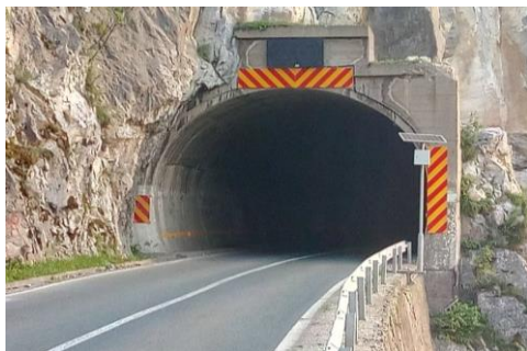
Slika 2: Dopunska signalizacija u tunelu
